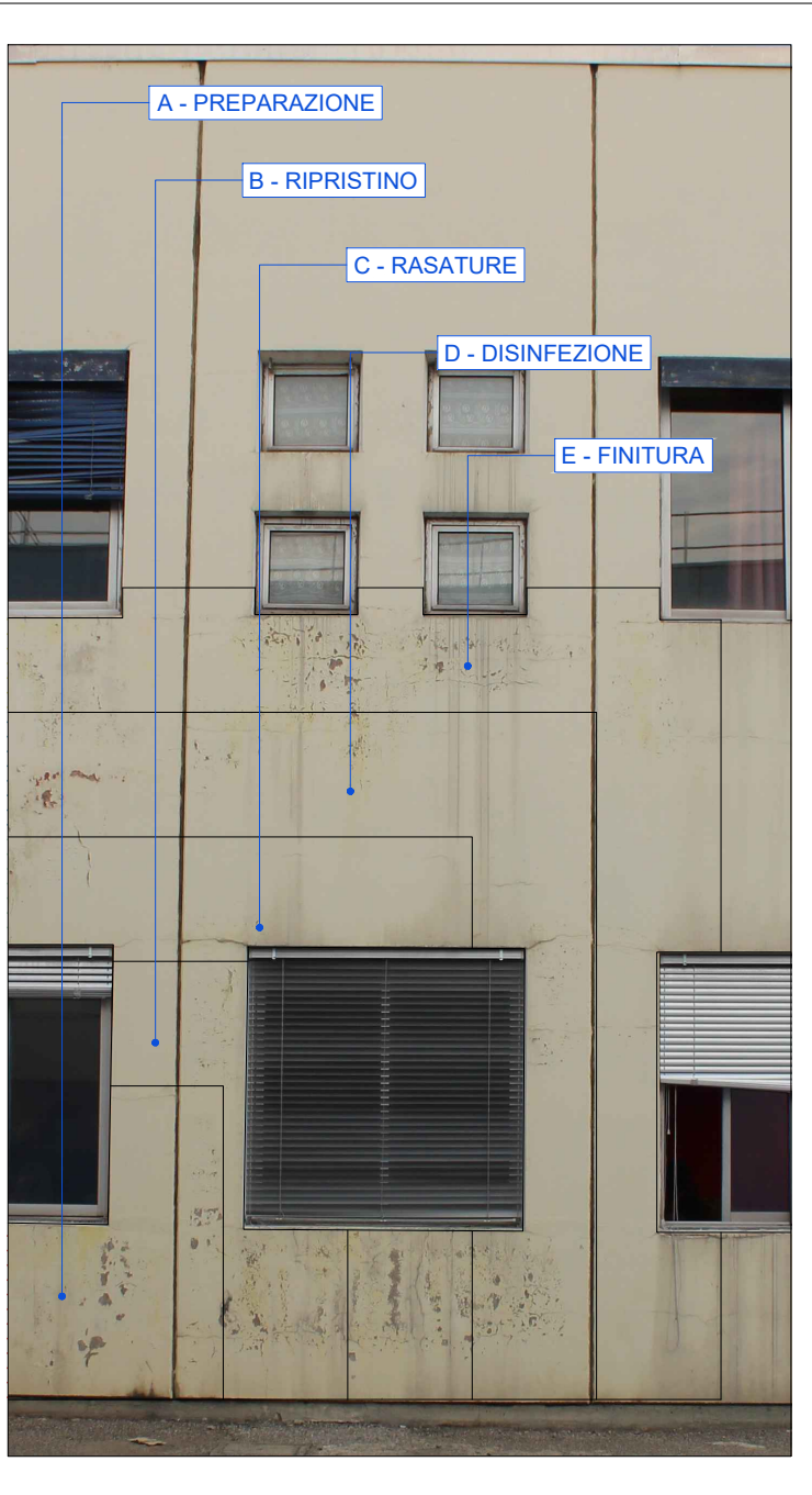
CICLO INTERVENTO 01 - Pannelli in calcestruzzo armato con anima coibente
